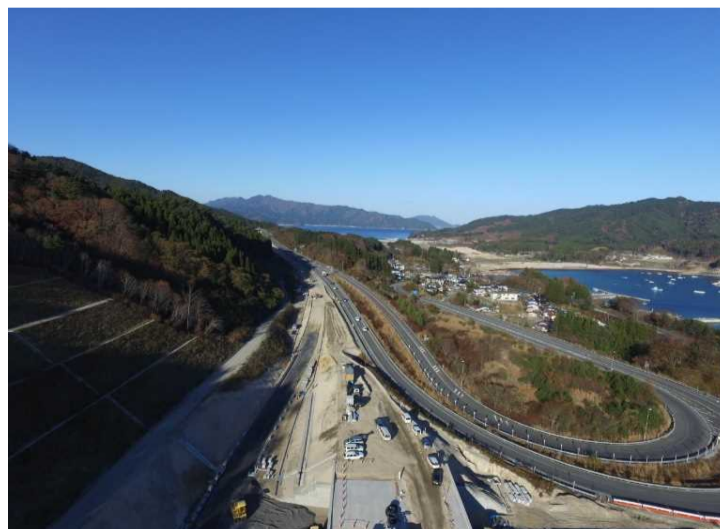
山田南IC 着工前 全景
