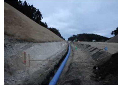
情報管路の敷設
