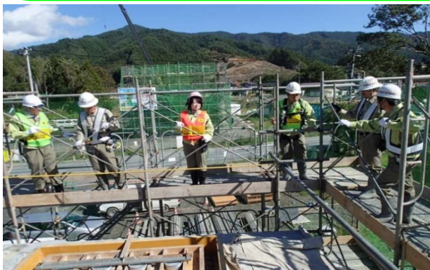
小槌第2トンネル工事(大槌高架橋) (橋脚足場上で点検)
