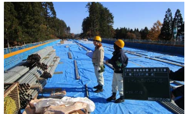
浪板高架橋上部工工事 (床版上で仮設材の点検)
