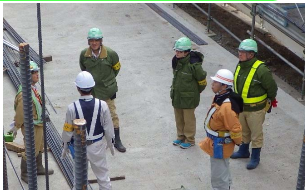
浪板北地区道路改良工事 (函渠工の現場で概要説明)
