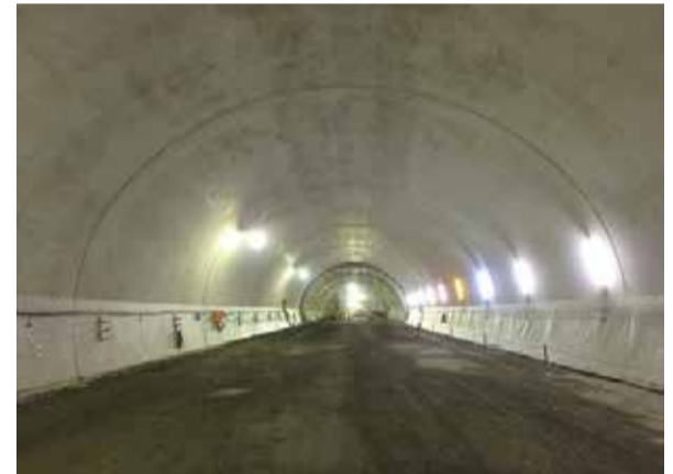
大槌第2トンネル坑内覆工コンクリート完了状況
