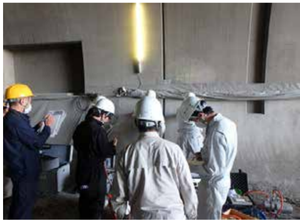
現地調査状況(坑口部)
