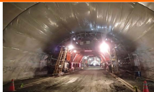
覆工コンクリートのビニルシート養生
