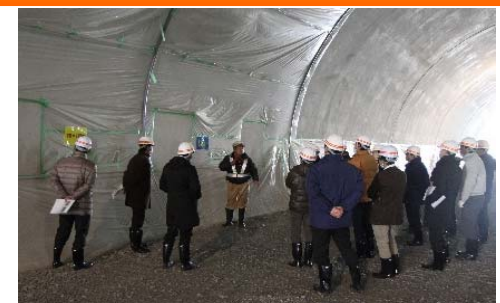
小鎚第1トンネルでの見学状況
