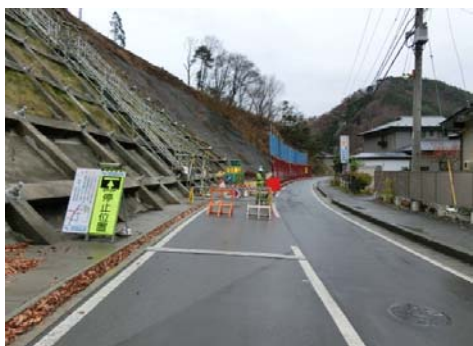
上り線側規制状況
