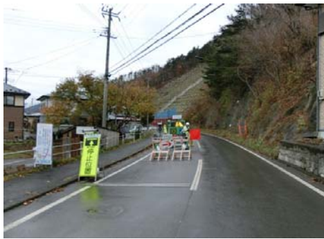
下り線側規制状況
