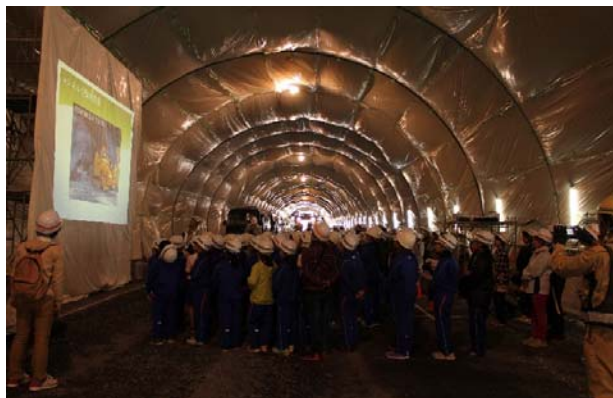
小鍬第1トンネル坑内でトンネルの掘り方を説明
