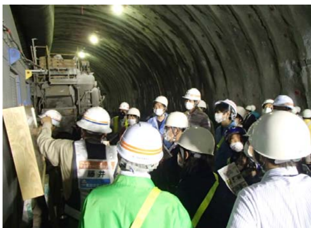
トンネル坑内での見学
