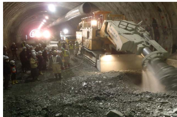
自由断面掘削機をリモコンで操作する小学生達
