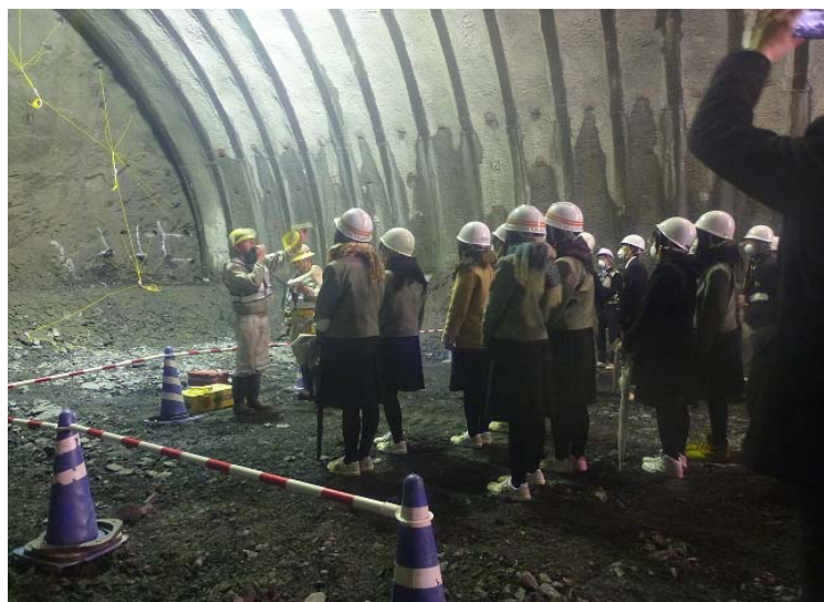
発破前、トンネル先端で発破のしほりを学習
