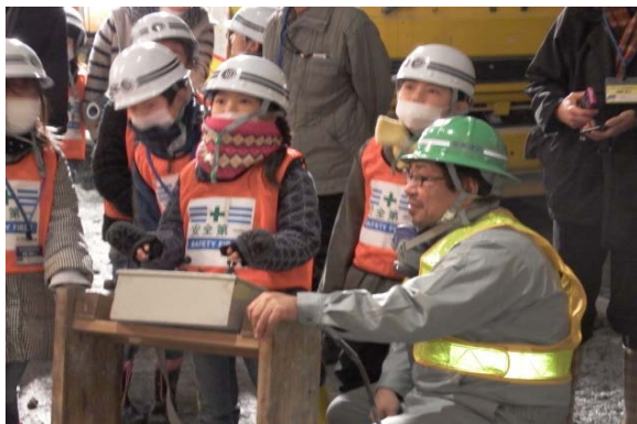
吹付機をリモコンで操作する小学生達
