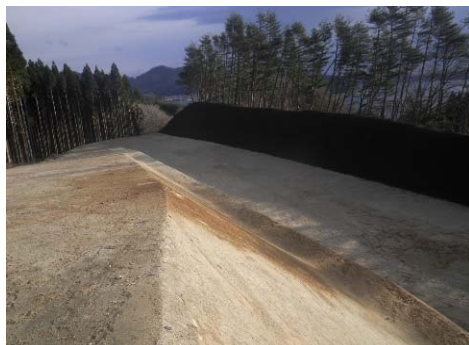
▲ 掘削工の施工区間
