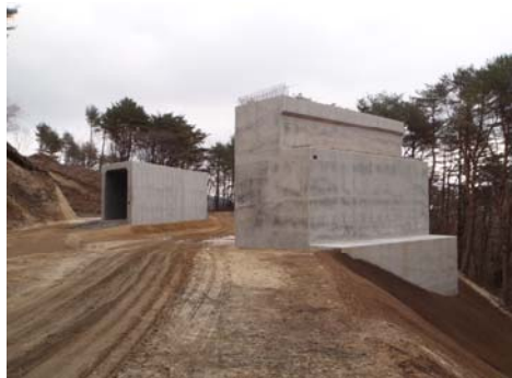
▲ (仮称)大沢第3橋のA2橋台と函渠工
