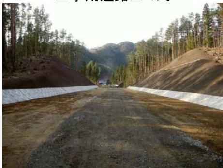
▲ 掘削工の施工区間
