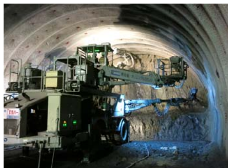
八雲第1トンネル 施工状況
