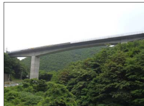
ひとつに繋がった水海高架橋(仮称)
