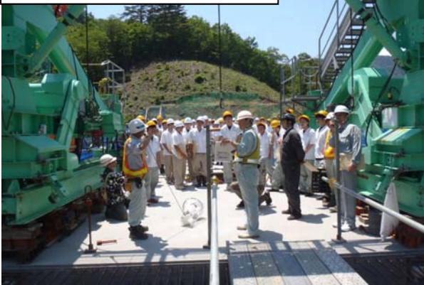
現場研修の状況(水海高架橋)
