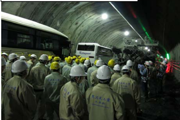
現場研修の状況(八雲第2トンネル)
