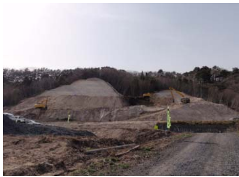
▲ 山田南IC付近の掘削状況
