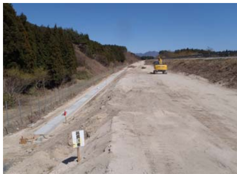
▲ 山田南IC北側の盛土状況
