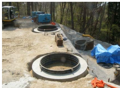
▲ 大沢第3橋(仮称)の深礎杭施工状況
