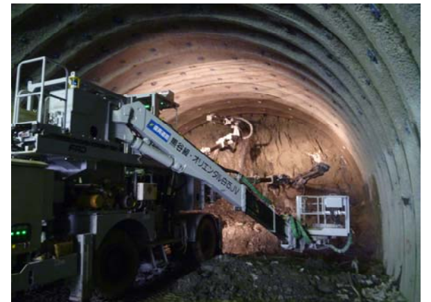
トンネル内の施工状況(発破孔の削孔中)
