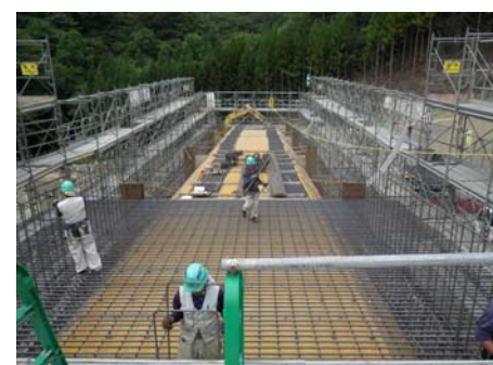
鉄筋組立状況
