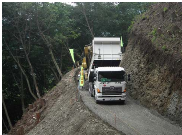
路盤材の搬入状況
