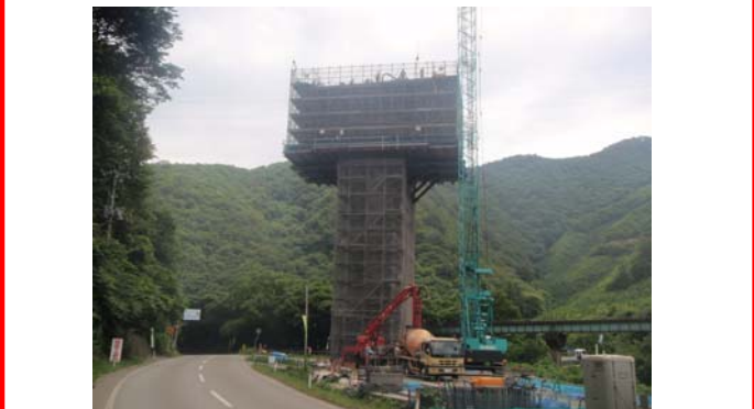
水海高架橋 P2橋脚（上部工施工中）
