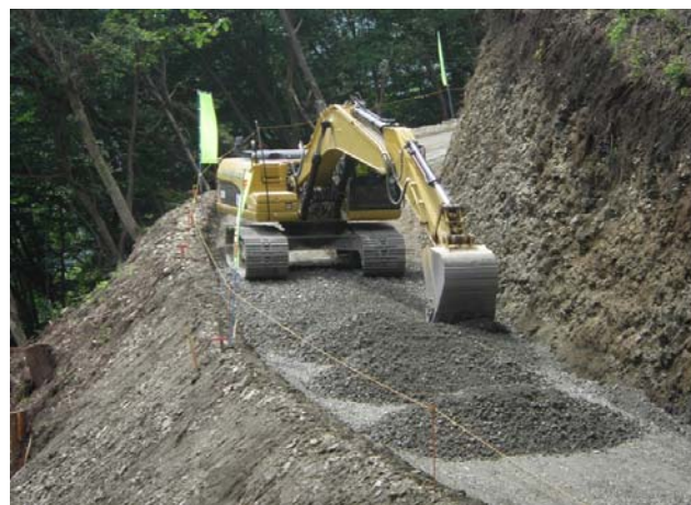
重機による敷均し作業
