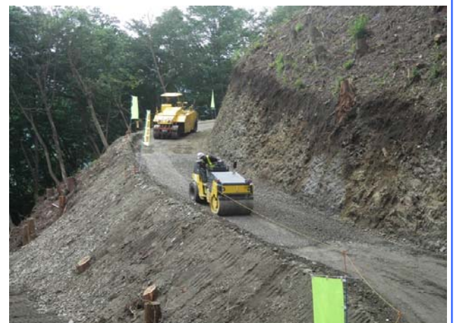
ローラーによる締固め作業
