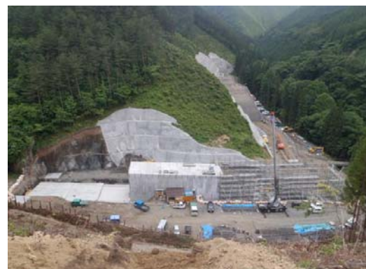
函渠工の施工状況
