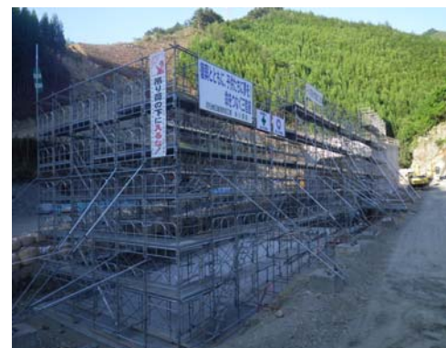
足場組立状況
