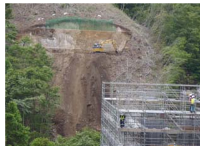
A1橋台掘削状況
