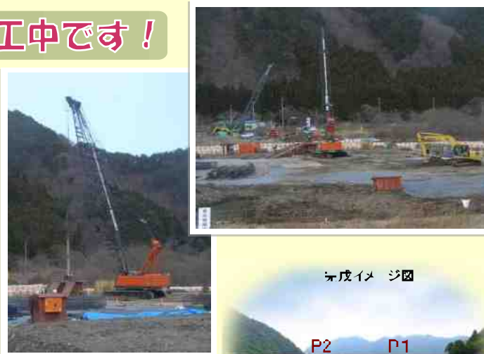
地中に鉄筋コンクリートの柱を造っています。
