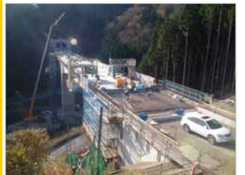
最後の閉合(橋をつなげる)作業の様子です。
