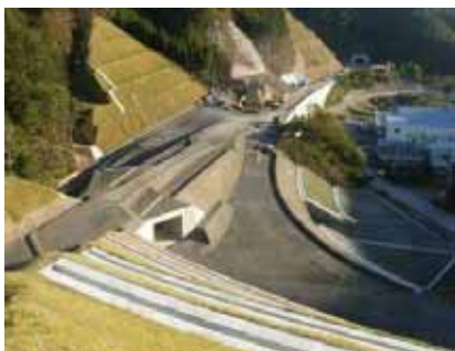
水海IC(仮)の改良工事が完成しました。
