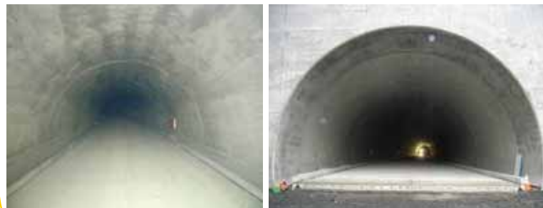
両石トンネル内の舗装工事が完成しました。
