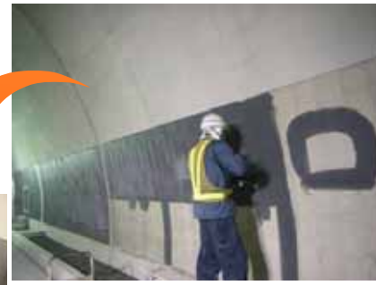
タイルを張るため接着剤を塗っています。
