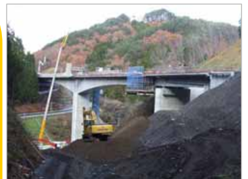
11月末で橋がつながります。今後は橋の上での作業になります。
