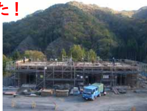
1階部分の壁を造っています。
