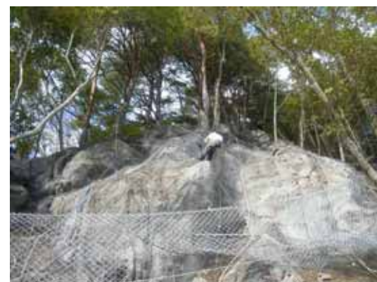
岩に網を掛けて落石を防止する作業です。
