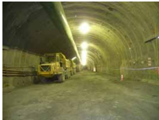
トンネル坑内の様子です。 掘削後コンクリートを吹き付けた状態です。
