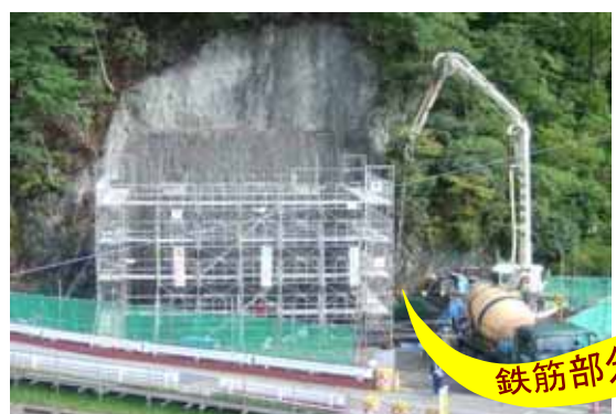
A2橋台の施工の様子です。 コンクリートポンプ車でコンクリートを流しています。
