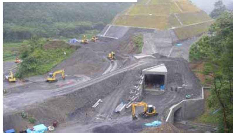
函渠工が完成しました！
