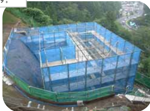
A2橋台の施工が始まりました。
