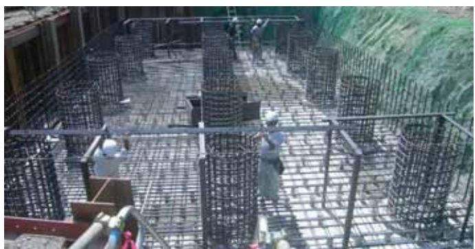
地中に鉄筋コンクリートの柱を埋め込み、橋台の土台を造っています。
