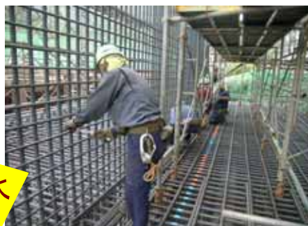
手作業で鉄筋を組み立てています。
