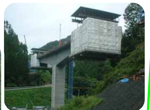
P2橋脚から左右に約50m伸びました。
