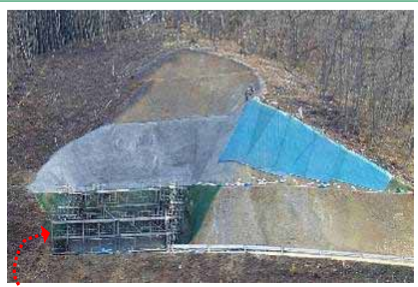
現在、橋桁を乗せる橋座部を造っています。
