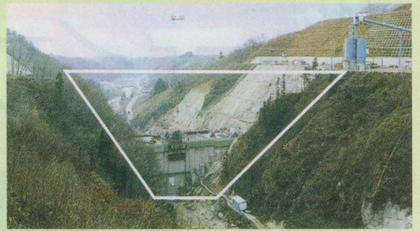
■堤体工事進捗状況(平成3年11月)
