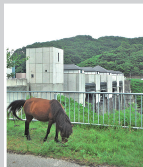
除草作業中(ポニー:涼風) -2023年7月撮影-
