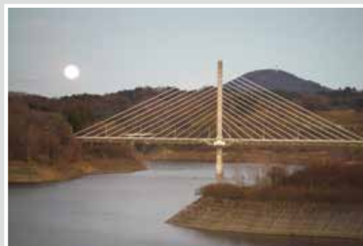
春田大橋とビーバームーン -2020年11月撮影-
