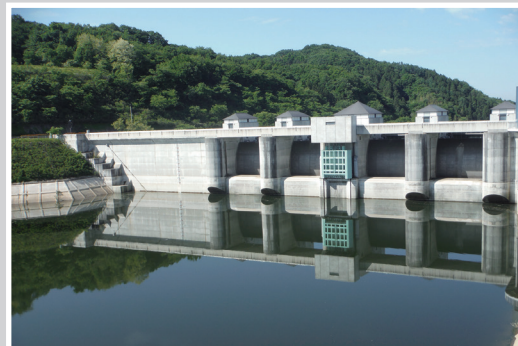
逆さダム - 2015年5月撮影 -
