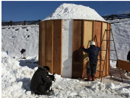
雪を締め固め後型枠を外します
