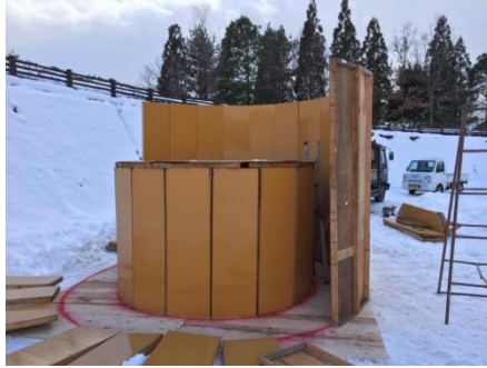
専用の型枠を組み立てます
