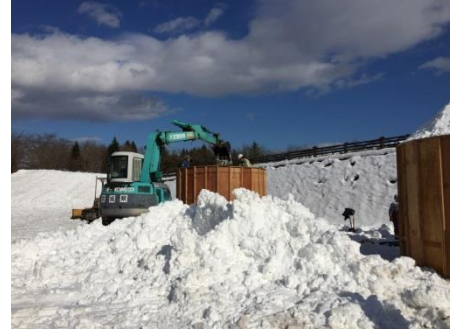
型枠に雪を詰めます
