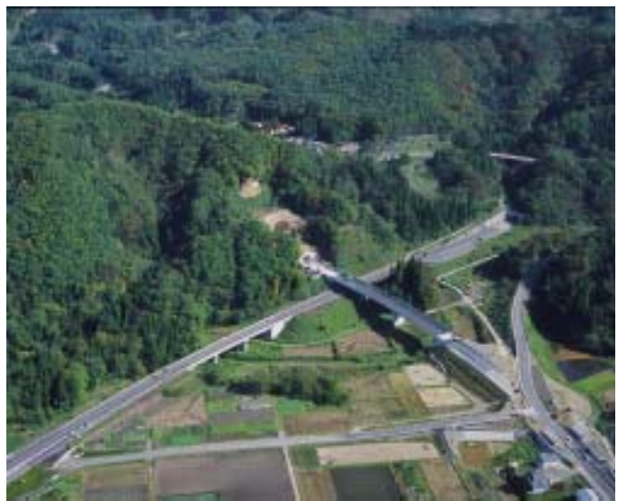
写真4 終点側から見た七折峠トンネル坑口
