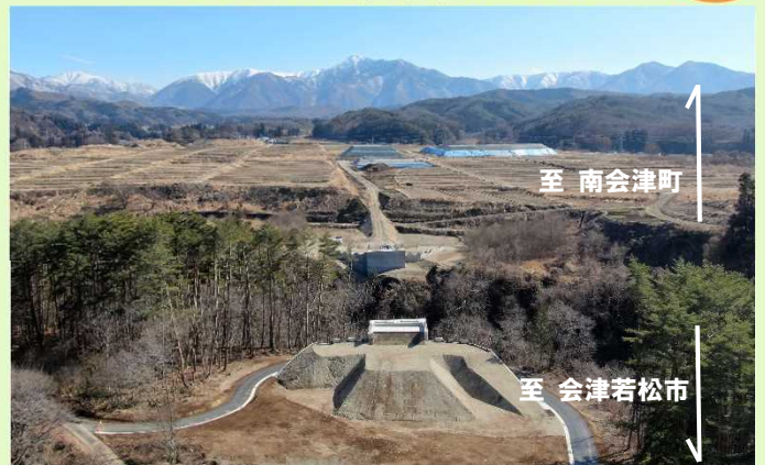
▲合川地区(6号橋) (仮)6号橋下部工の施工が完了しました。 撮影日:2023年3月15日
