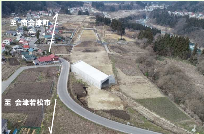
▲中妻地区 地盤改良工及び盛土工の施工が一部完了しました。 撮影日:2023年3月23日
