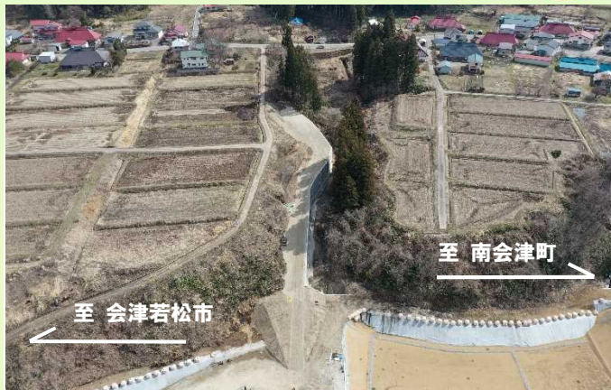
▲中妻地区 盛土工及び補強土壁工の施工が一部完了しました。 撮影日:2023年3月21日
