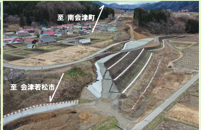
▲中妻地区 盛土工及び町道栄富線の施工が一部完了しました。 撮影日:2023年3月24日
