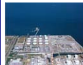
LNG輸入基地となる新潟港
