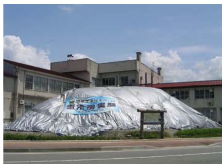
庁舎裏側の雪室
