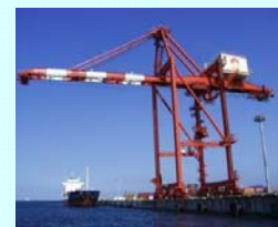
仙台塩釜港高砂ターミナル外資定期コンテナの荷役で利用するガントリークレーン ▶
