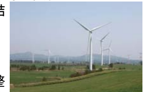
▲六ヶ所村二又風力発電所 (出典:東北経済産業局提供)
