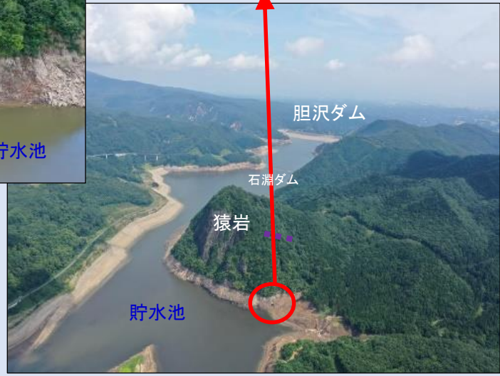
猿岩隧道(トンネル) 北側
