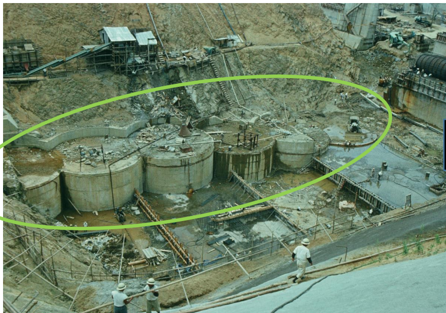
施工中の状況
