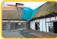
施工前の様子(写真提供:御所湖広域公園)
