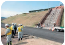
御所ダム管理所構内
