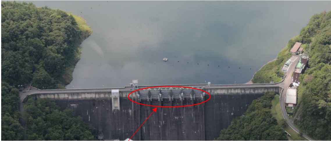
放流設備補修
