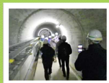
⑤堤体内部 (約800m、階段有)
