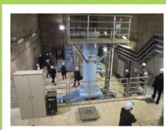
④利水・緊急放流ゲート室
