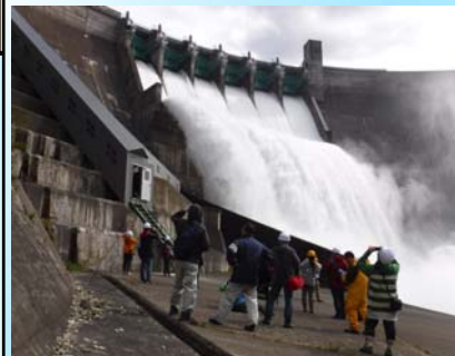
ダムアワード関係者を対象とした現場見学会（ダム右岸直下へ案内して大好評でした。）
