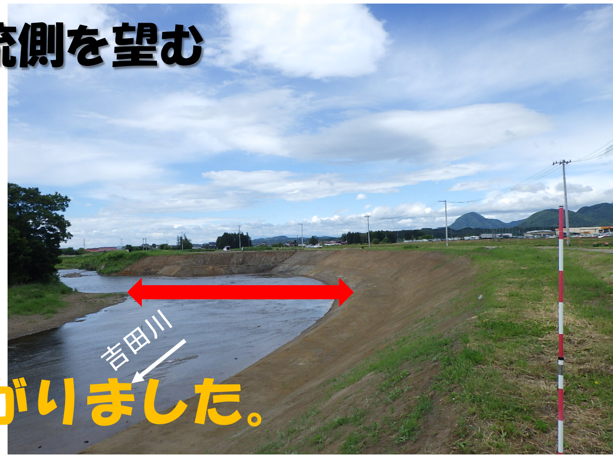
② 河道掘削状況
