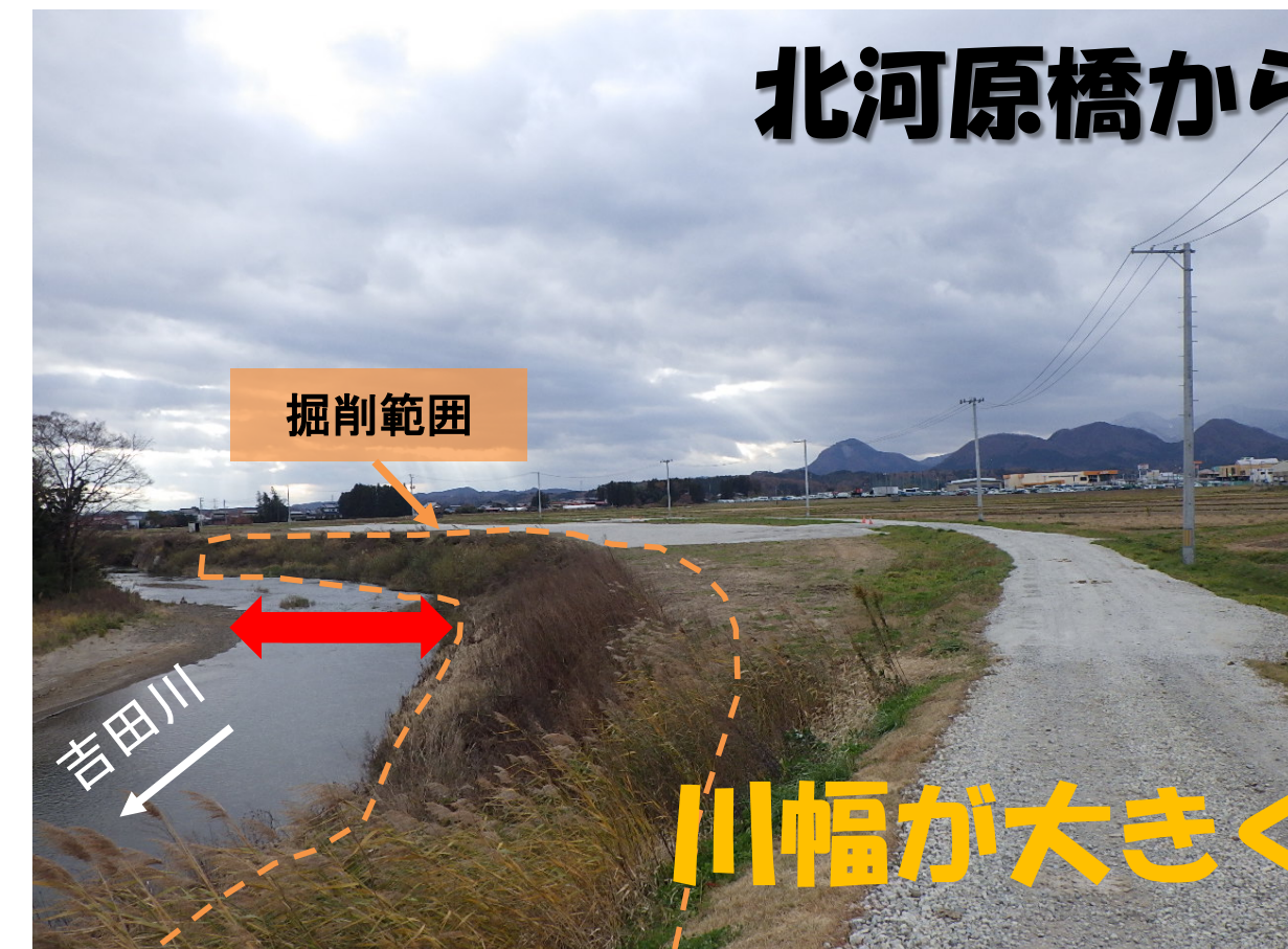
① 工事着手前
