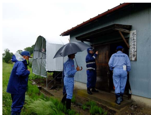
▲江合川左岸16.4k 北小牛田 水防倉庫の巡視
