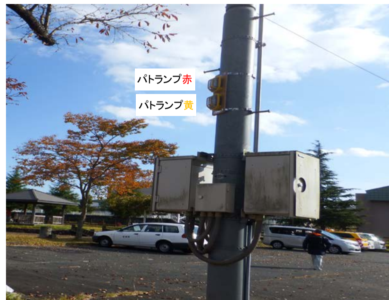
簡易アラート設置状況（H28.11.2）
