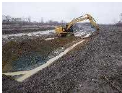
河道掘削 (石狩川水系、北海道開発局)
