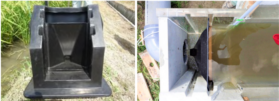
【田んぼの排水ますに設置する調整装置】
