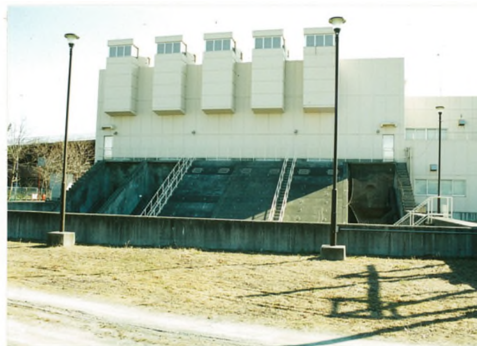
(事例)防水扉等により耐水化された湊雨水排水ポンプ場 (宮城県石巻市川口町)
