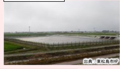
大曲雨水調整池
