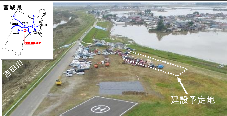
令和元年東日本台風における水防災拠点の活用状況（2019年10月14日）
