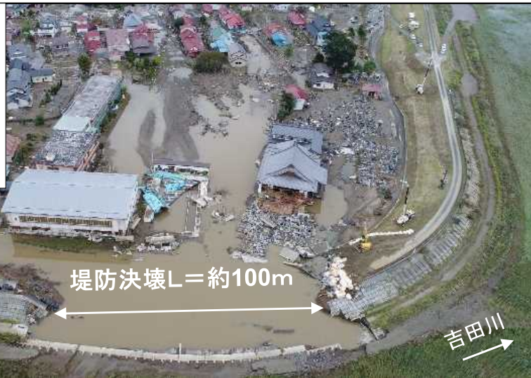
粕川堤防の決壊直後（2019年10月14日）
