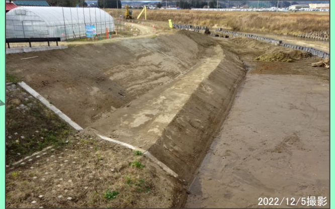
落合舞野地区 法覆護岸工 (現場打護岸) 施工中
