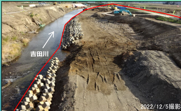
上川原地区 全景写真(起点側)
