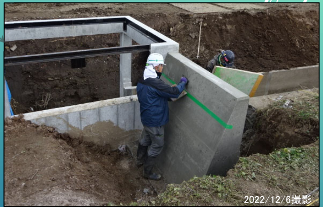
持足排水路 水路工（重力式擁壁コンクリート打設） 施工中
