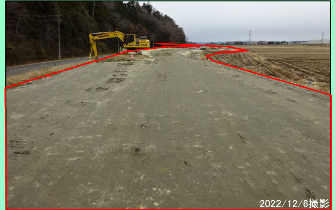
周囲堤部 河川土工(法面整形) 施工中
