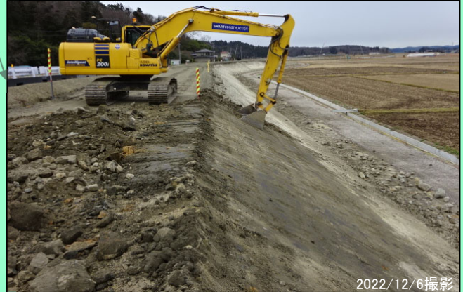
周囲堤部 河川土工(法面整形) 施工中
