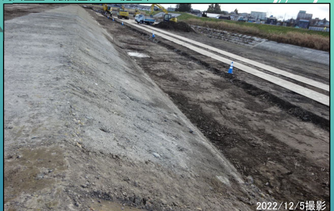
越流堤部（川表） 河川土工（法面整形） 施工中
