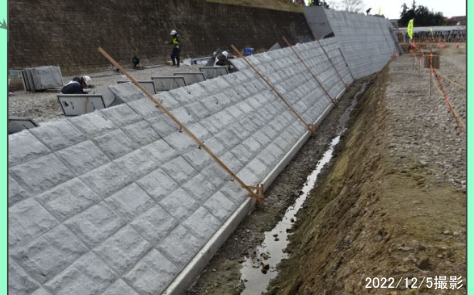
落合舞野地区 法覆護岸工 (現場打護岸) 施工中
