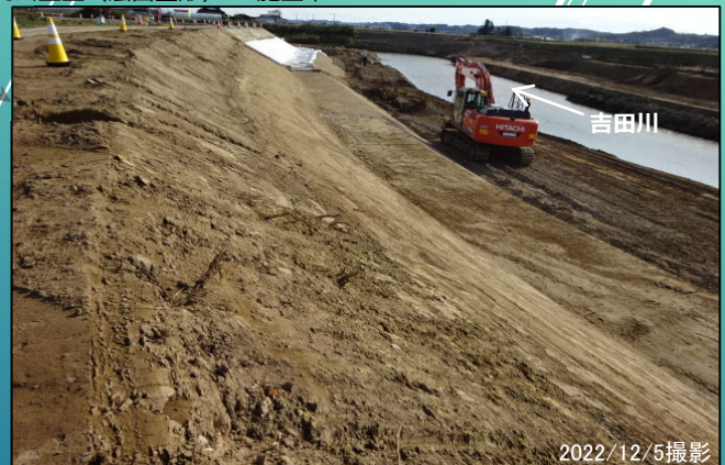
桧木川原地区 河川土工（法面整形） 施工中
