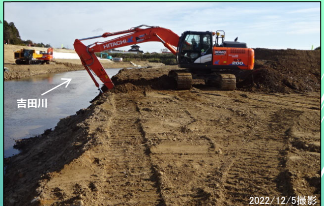
上川原地区 河川土工(河道掘削) 施工中
