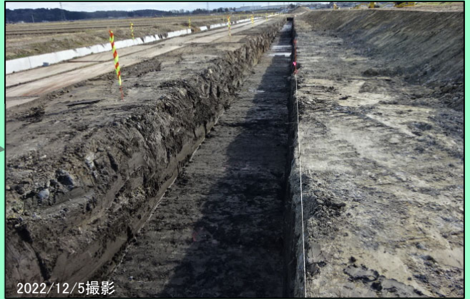
越流堤部 河川土工（法面整形） 施工中
