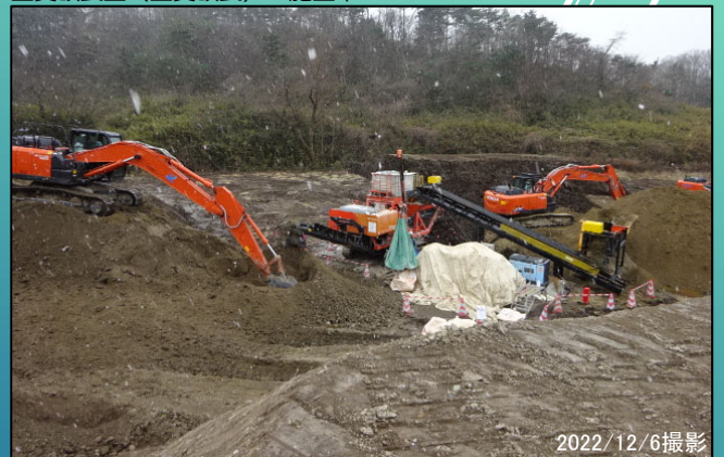
大衡ヤード 土質改良工 (土質改良) 施工中
