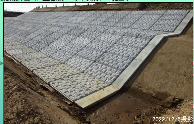
桧木川原地区 河川土工（法面整形） 施工中
