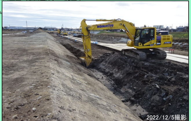
越流堤部 河川土工（法面整形） 施工中
