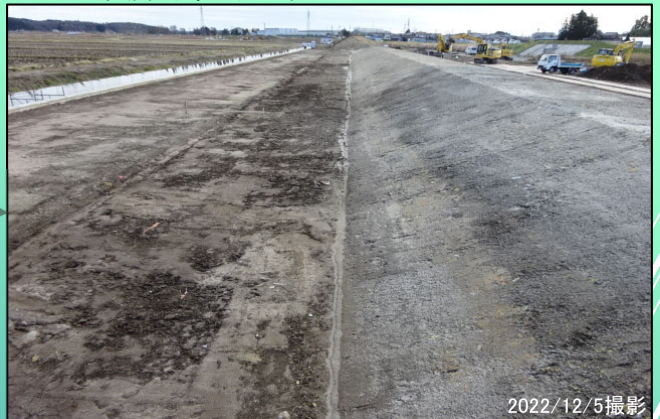
越流堤部（川表） 河川土工（法面整形） 施工中
