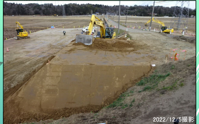
大衡ヤード 土質改良工 (土質改良) 施工中
