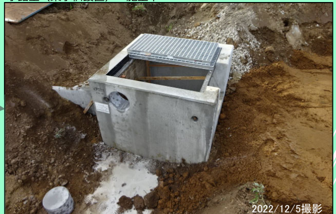
南岡江地区 河川土工（路体盛土） 施工中
