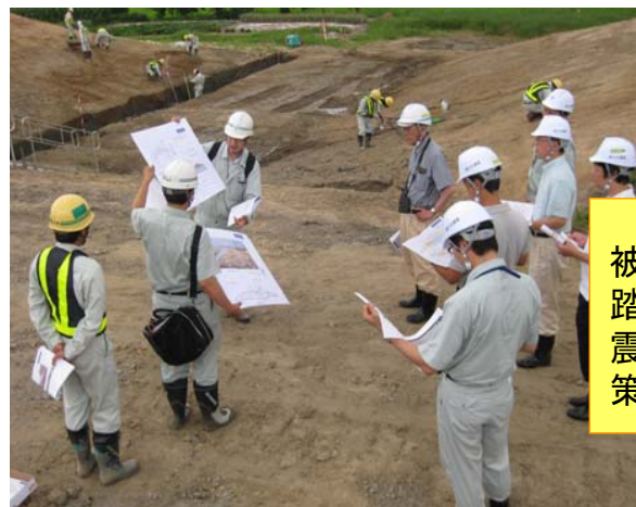
堤防被災の原因調査状況
