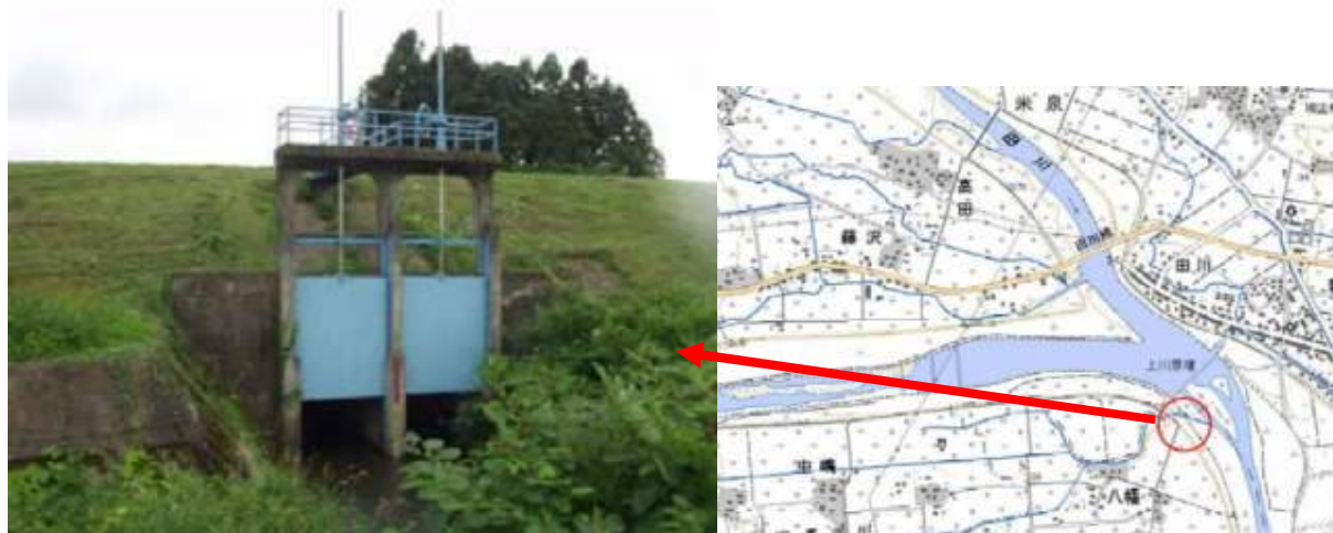
旧長谷川排水樋門とその位置
