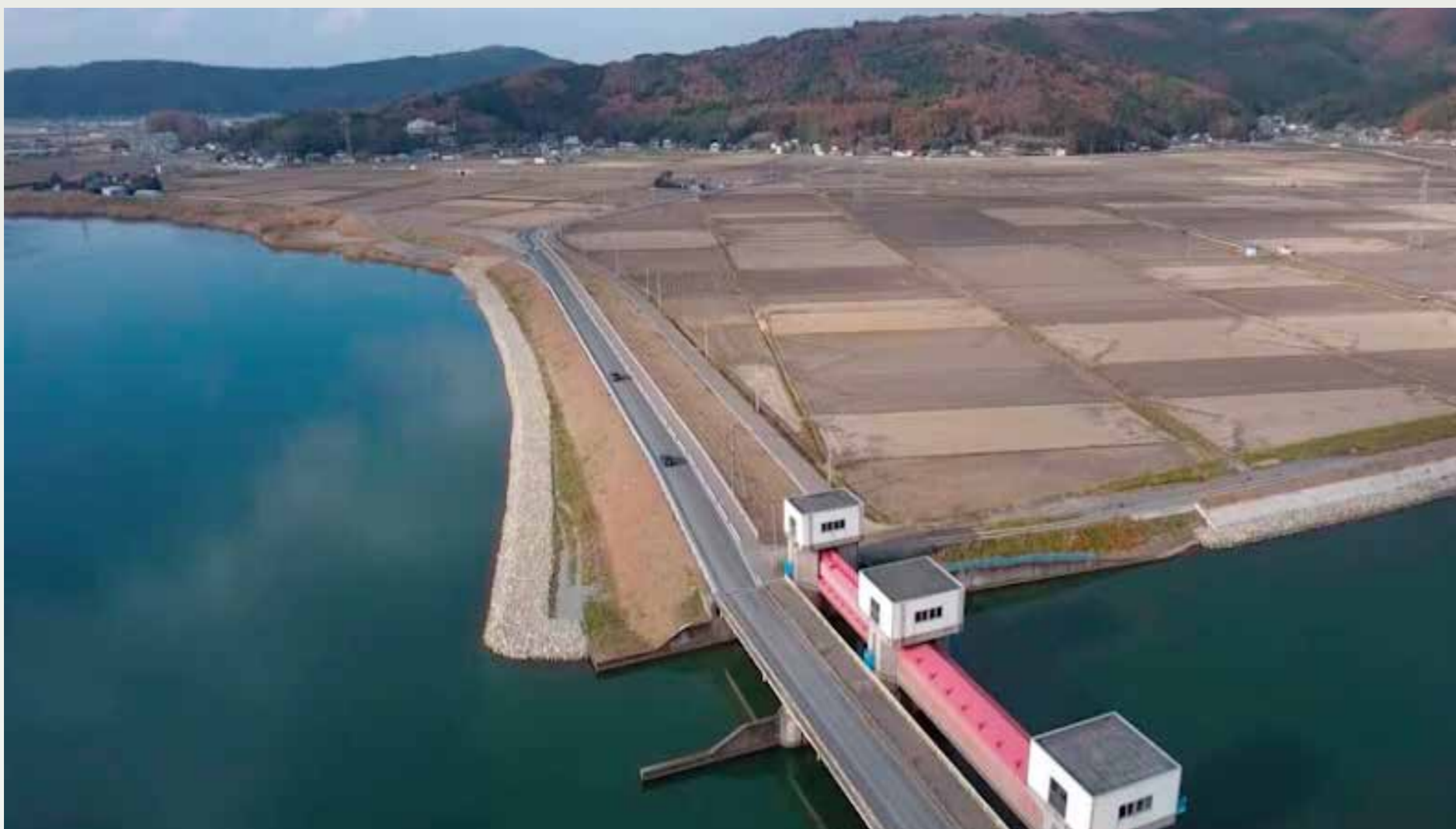
整備状況 [平成 30 年 11 月 ドローン撮影]
